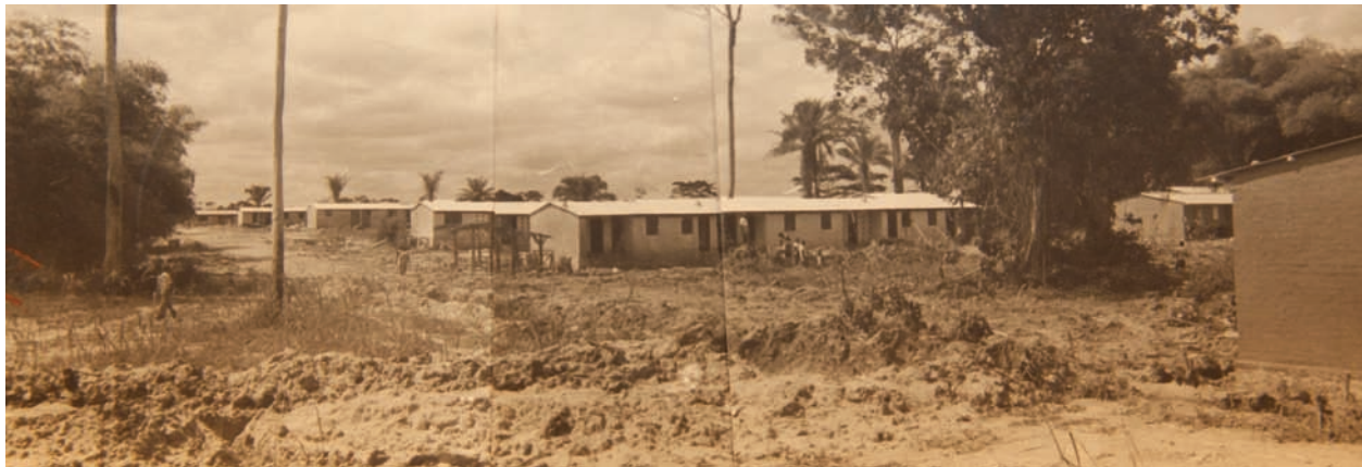
(Op de foto is te zien hoe deze woningen nog niet voorzien waren van de nodige infrastructuur. Bron: Sud du lot B: quartier 2 Mangobo , 15 mei 1954. In: AA, Inventaire O.C.A. dossiers, portefeuille 767, liasse 3204.)
